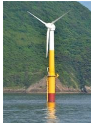
浮体式風力発電の設置例
