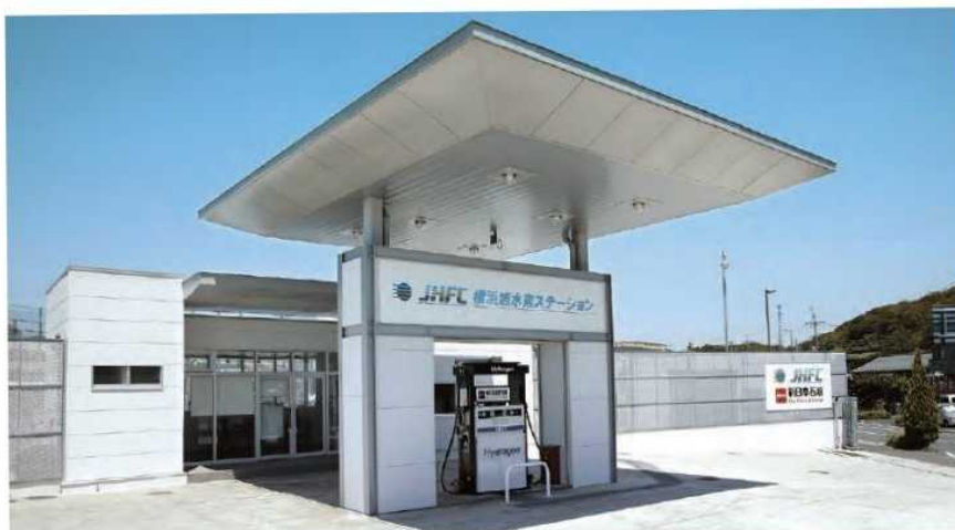
JHFC横浜・旭水素ステーション JHFC Yokohama-Asahi Hydrogen Station
