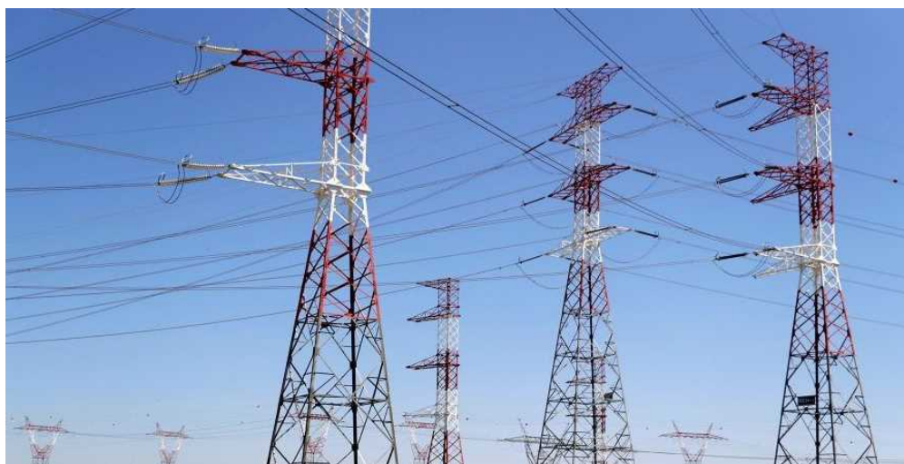
超高压送電ケーブルと鉄塔
